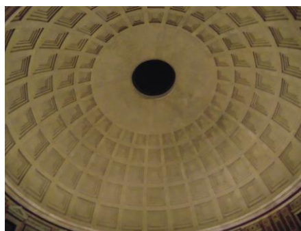
Figura 5: Caixotões da cobertura do Panteão de Roma. Fonte: Autores (2015).
