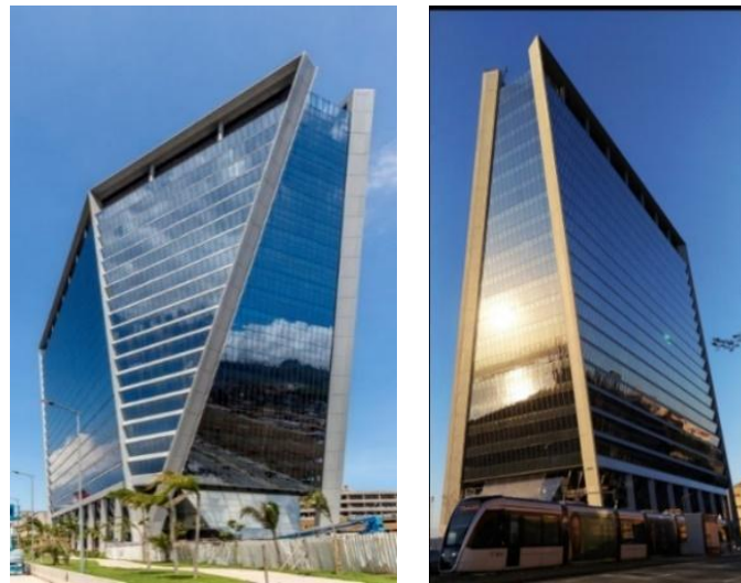
Figura 5 – Fachada oeste do Edifício Acqua Corporate. Região portuária do Rio de Janeiro. Fonte: http://tiny.cc/246tuz (Acessado em: 05/02/22).
