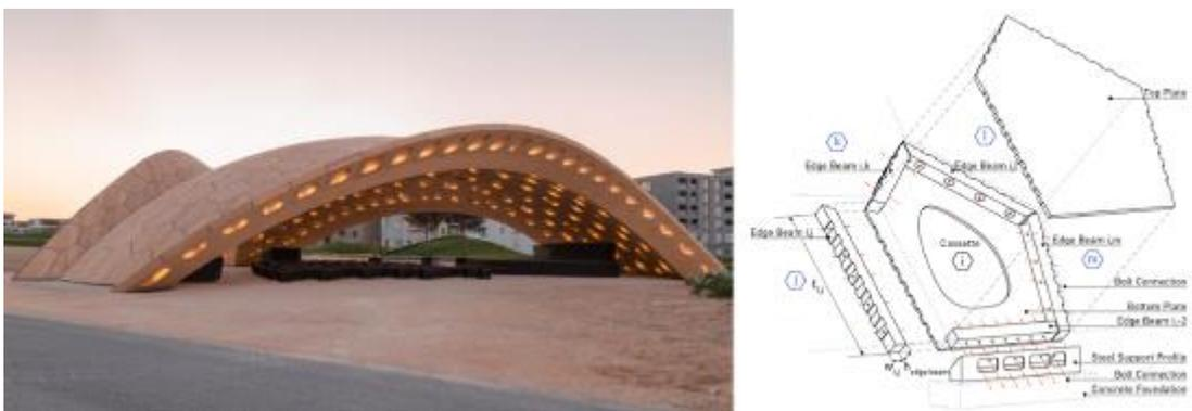
**Figura 4** – Gridshell que combina elementos de barra não prismáticos e elementos de casca (BECHERT, 2021)
