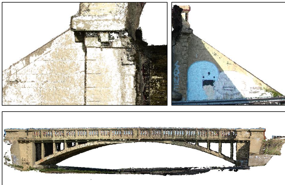
Figura 7 – Modelo fotogramétrico del Puente. Fuente: de los autores
