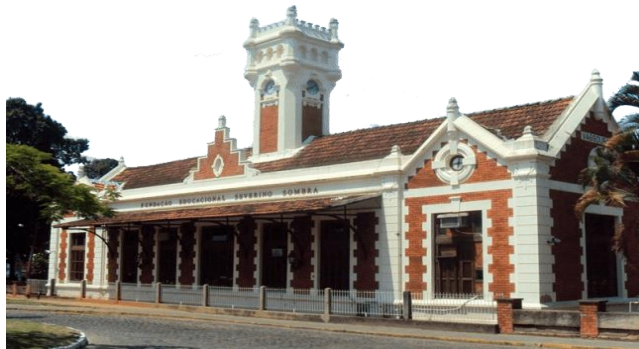
Figura 12 – Fotografia. Estação Ferroviária de Vassouras, RJ. Fonte: Agências Postais.
