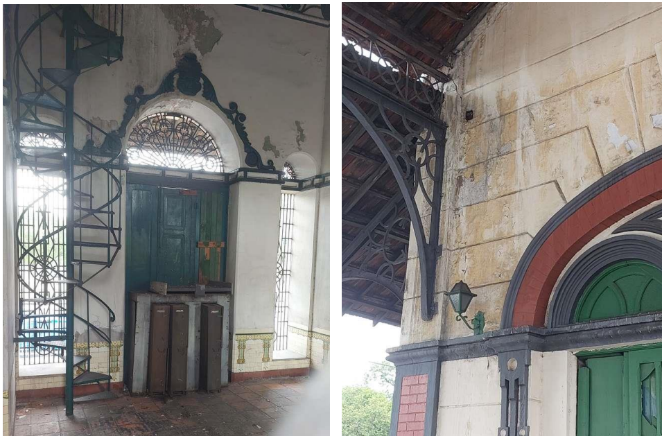
Figuras 2 e 3 - Fotografia. Vista do espaço interno do edifício histórico a partir da plataforma e parte da fachada lateral externa em situação de abandono. Fonte: do autor.
