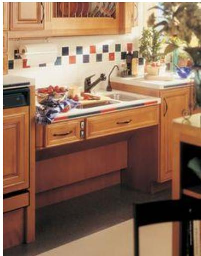
**Figura 2** – Bancada da pia que permite encaixe da cadeira de rodas
