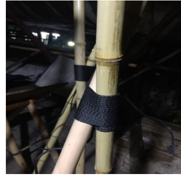
Figuras 2 y 3 - Maqueta domo acústico construido con fibras bambú, barro y resina de mamona. Detalle embarrillado y nudo escondido en estructuras colaborantes en Bambú phyllostachys aurea Fuente: Autores
