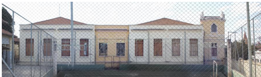
Figura 4 – Fotografia da fachada lateral da Escola Estadual Eugênio Franco, São Carlos. Fonte: Acervo dos pesquisadores.
