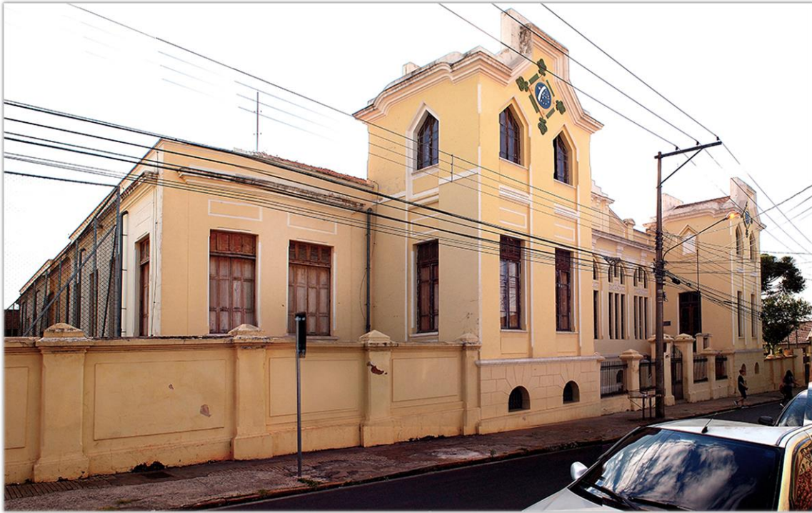
Figura 10 – Fachada da Escola Estadual Eugênio Franco, São Carlos. Fonte: Acervo dos pesquisadores.
